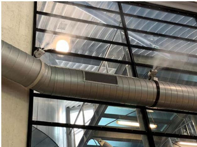
De adiabatische bevochtiging, te zien als wolkjes nevel die zich in de ruimte verspreiden (foto Gabriëlle Beentjes).
